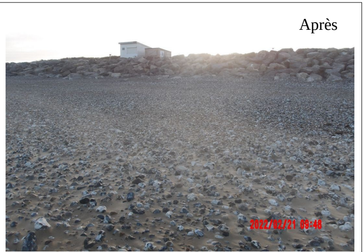
Ouvrage RTE recouvert par les galets au 21/02/2022
