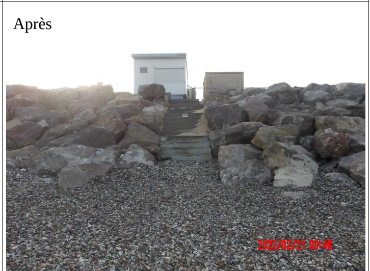
Escalier 5 : niveau des galets stable
